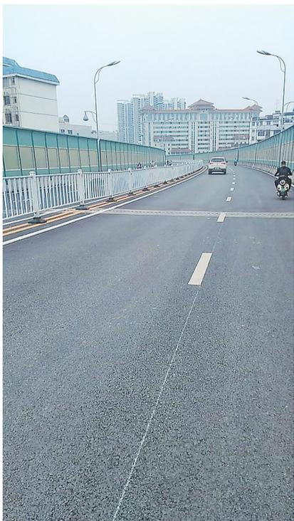
北大桃源连接线桥桥面翻新完工,沥青罩面提高行车条件
